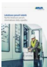
Lokalizace poruch kabelů
